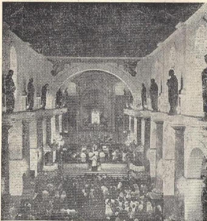
Interior da Catedral que está sendo demolida — 1965
