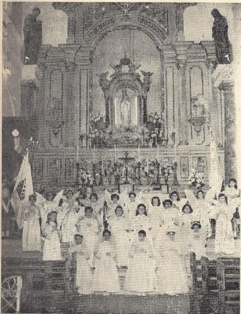
Altar mór da Catedral que está sendo demolida Gentileza Foto Arte-Pipeta
