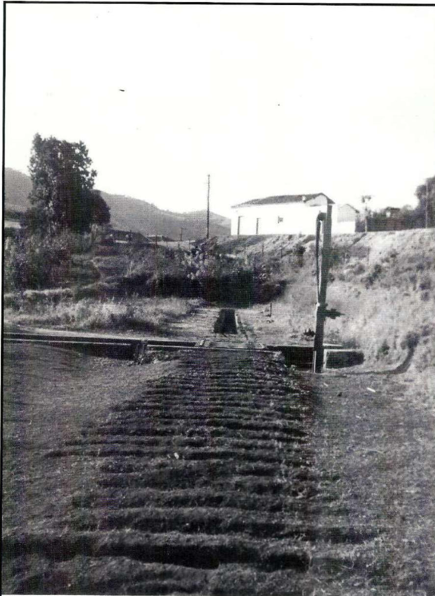
Pátio de Vargem, 1970. Lavador de gaiolas e valeta de manutenção, logo após a retirada dos trilhos. Foto de F. C. Araujo.
