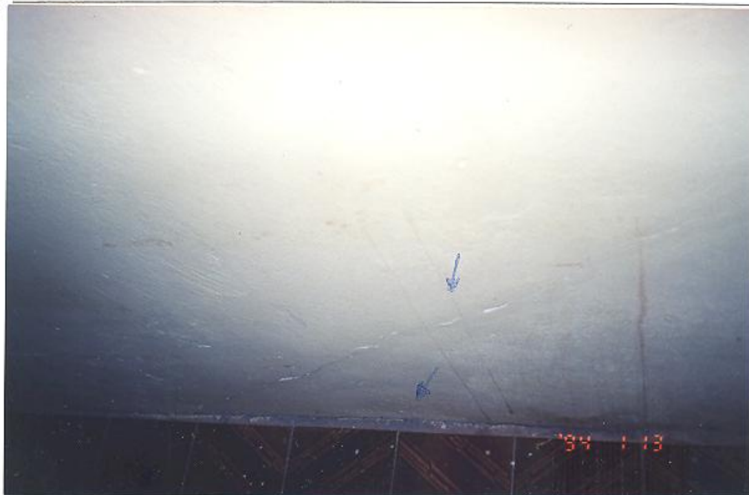
Foto 09 - Visão de uma das trincas na parede e um pequeno afastamento no chão do imóvel
