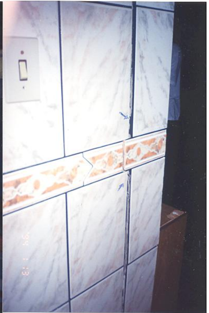
Foto 05 - Visão da parede da casa na qual encontra-se encostado o muro do imóvel da rua Ouzono, onde se vê umidade
