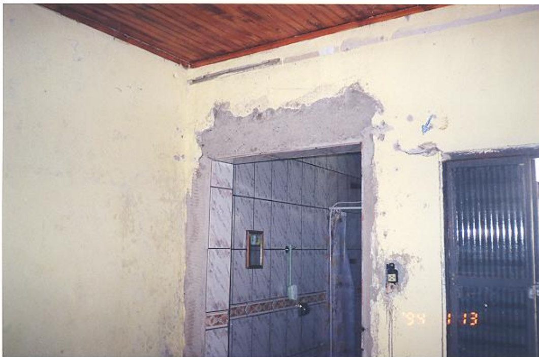
Foto 08 - Vista da mesma parede acima
