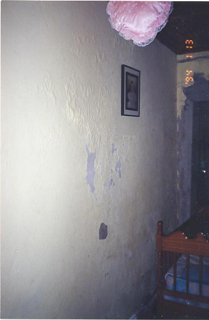
Foto 05 - Visão da parede da casa na qual encontra-se encostado o muro do imóvel da rua Ouzono, onde se vê umidade
